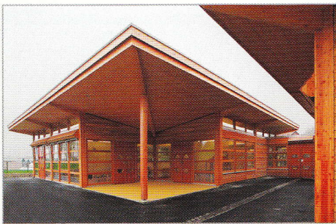
Détail sur pavillon
